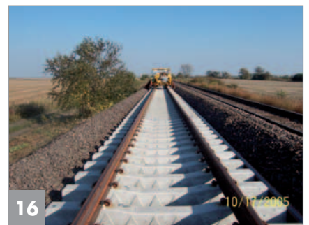
Die patentierten CXT®-Betonschwellen
