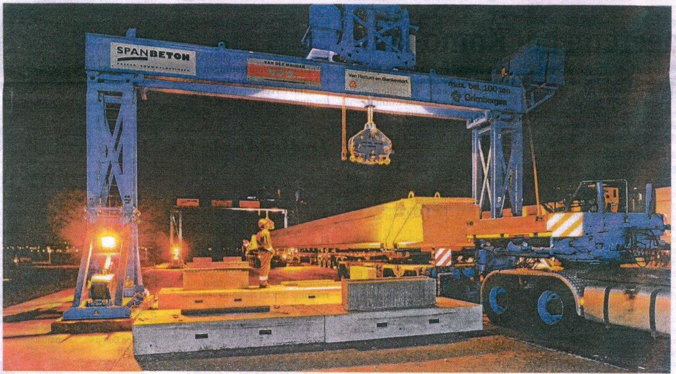
Aankomst van de betonnen liggers op de bouwplaats aan de Westrandweg. Foto: Georg Tjepkema
